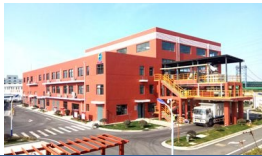
苏州相城污泥处置和资源化利用项目
