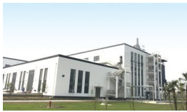
扬州污泥处置和资源化利用项目
